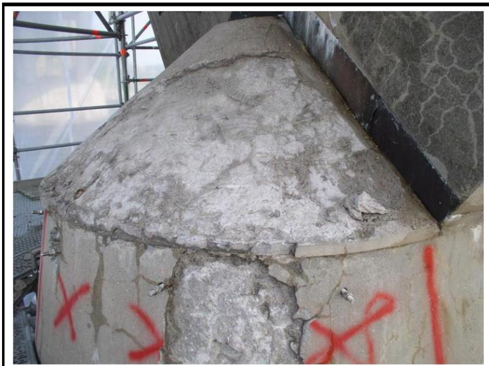
Foto 9:(beton i gang med at blive behugget)
