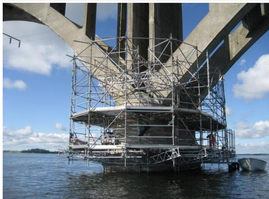
Foto 5:(Færdigt stillads på pille 3)
