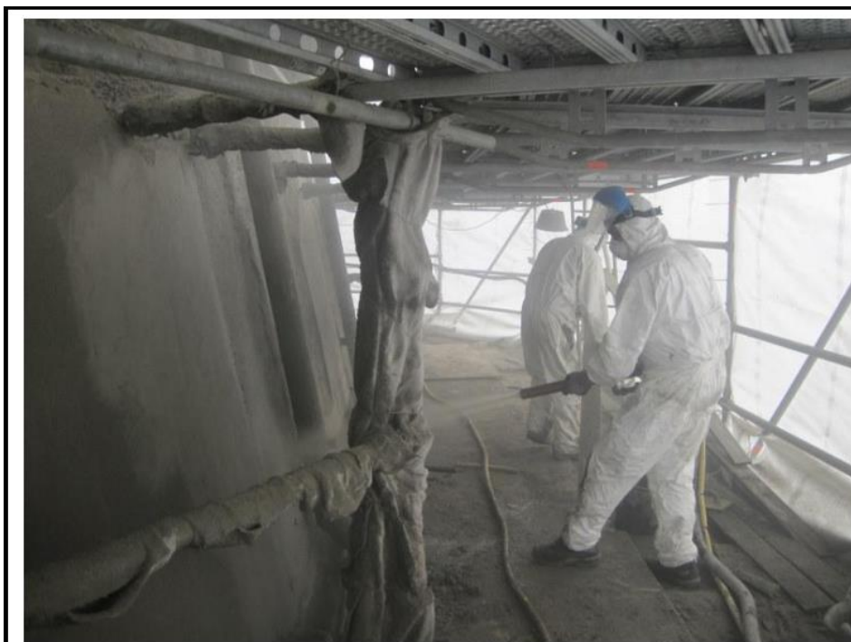
Foto 16:(sprøjtebeton udførelse på pille 6)
