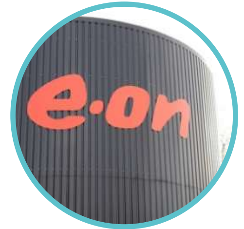
Akkumuleringstank giver 10-20 timers varmforsyning
