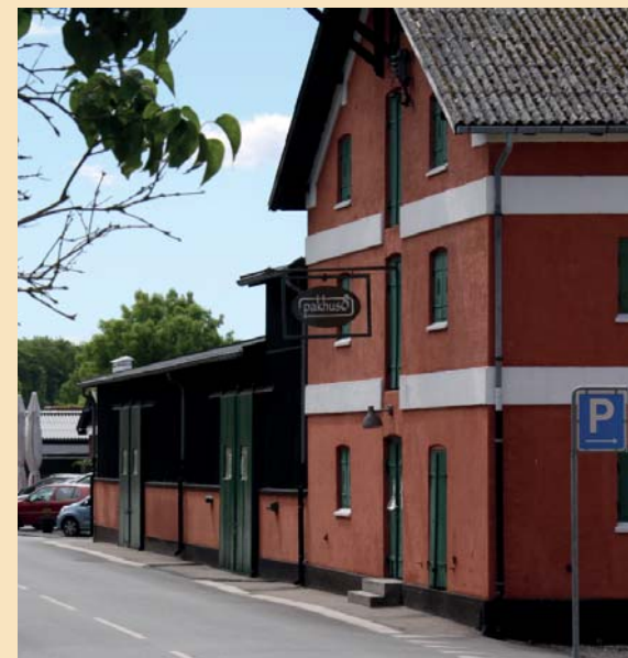
Fredet pakhus, Præstø Havn, med udhængsskilt
