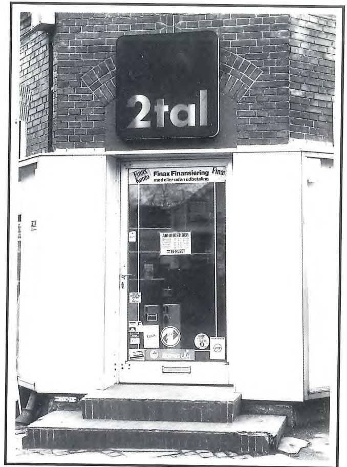
Et eksempel på hvorledes bygningsdetaljer skjules af skilte og facadebeklædning.
