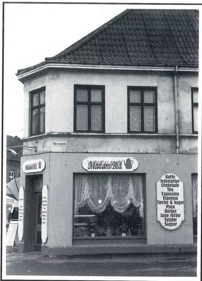
Et eksempel på en facadebeklædning som er fremmed for husets oprindelige udseende.
