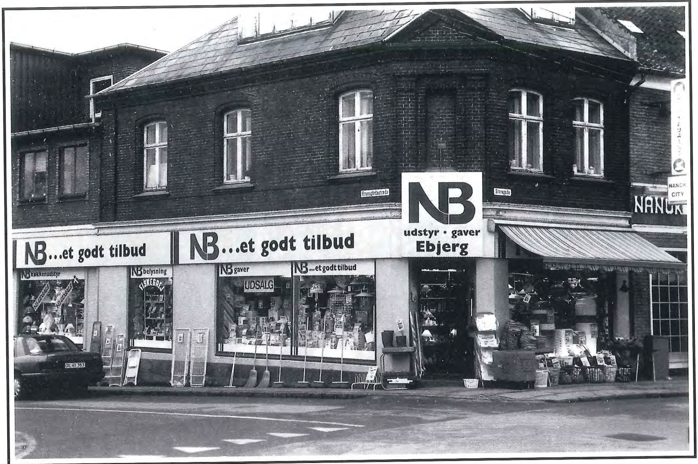
En meget dominerende skiltning, som ikke respekterer facadens opbygning.
