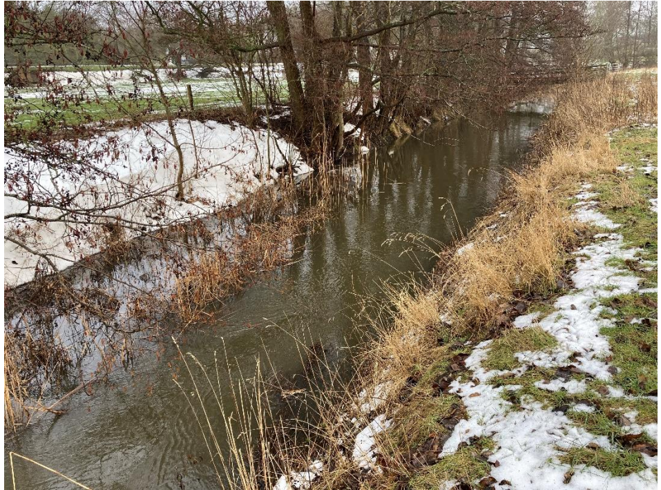
Figur 3-35: Nedstrøms Mønvej er vandløbet dybt og bredt. Skånsom vedligehold er ved at opbygge brinkfodder og skabe variation, men vandløbet er fortsat overbredt og overuddybet. Foto: NIRAS 2021-02-18
