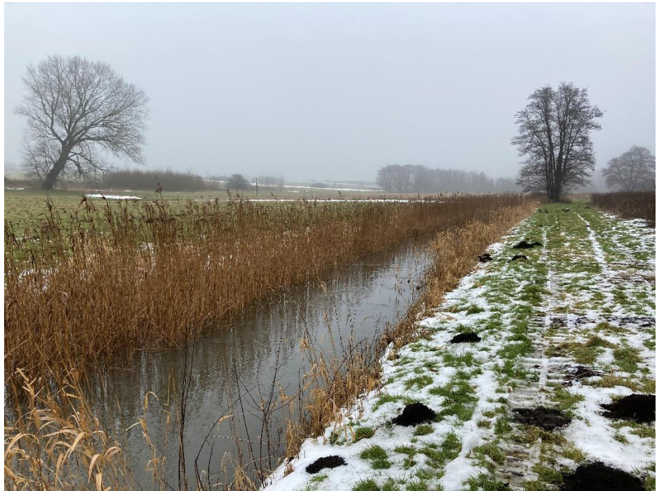
Figur 3-29: Tubæk Å st. ca. 2550. Vandløbet var tidligere stærkt mæandrerende og lå i store slyng ud over engene i den brede ådal. Vandløbet er nu kanaliseret på hele strækningen og har ikke hydraulisk forbindelse med ådalen. Foto: NIRAS 2021-02-18.
