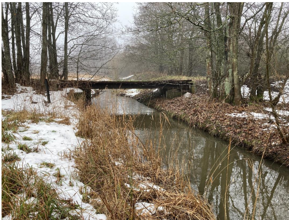
Figur 3-17: Ved passagen af broen i st. 3865 er vandløbet beskyttet fra begge sider. Her ligger vandløbet fortsat i et overbredt og reguleret profil da vegetationen ikke har kunne indsnævre profillet. Foto: NIRAS 2021-02-18.
