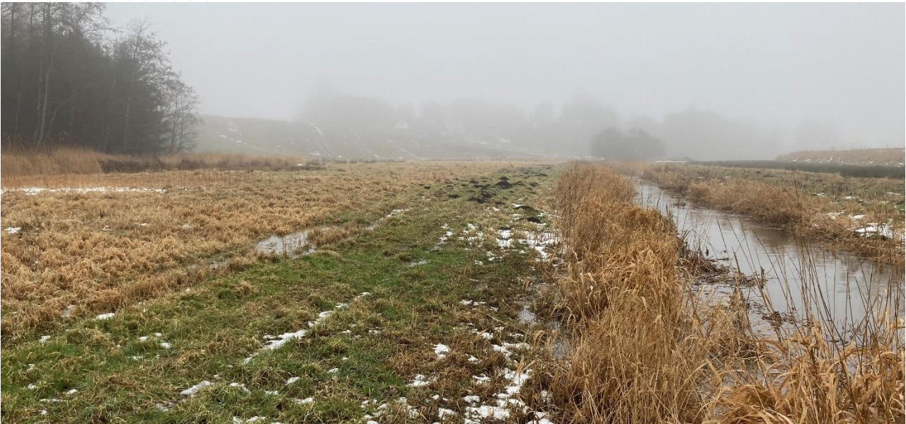
Figur 3-25: Tubæk Å st. ca. 1000 set nedstrøms. Vandløbet var tidligere stærkt mæandrerende og lå i store slyng ud over engene i den brede ådal. Vandløbet er nu kanaliseret på hele strækningen og har ikke hydraulisk forbindelse med ådalen.
