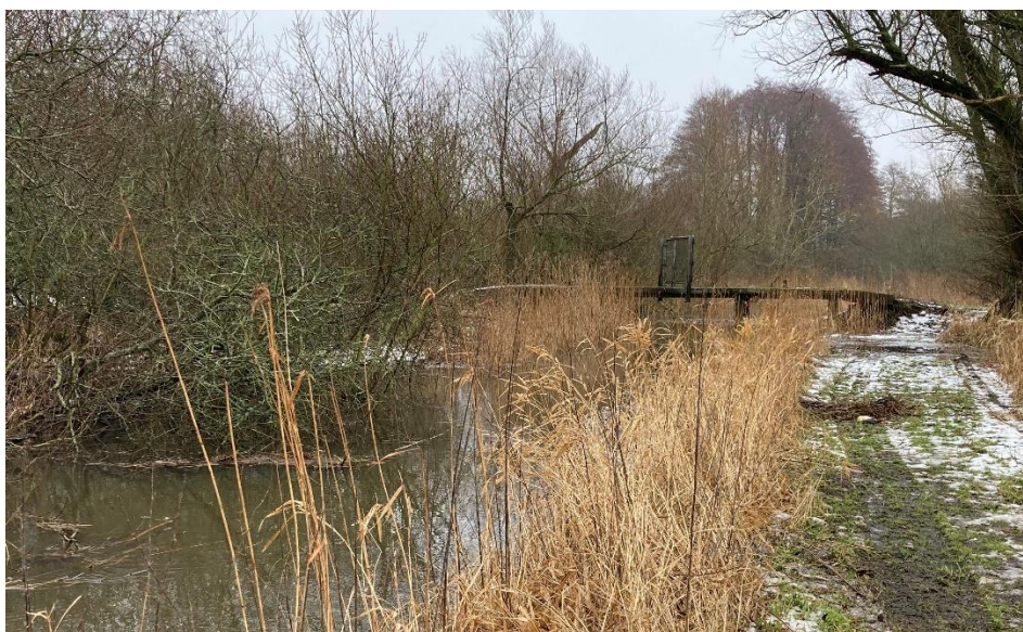
Figur 3-32: Betonbroen i st. 3777. Broen er lukket med hegn og låge. Foto: NIRAS 2021-02-18.
