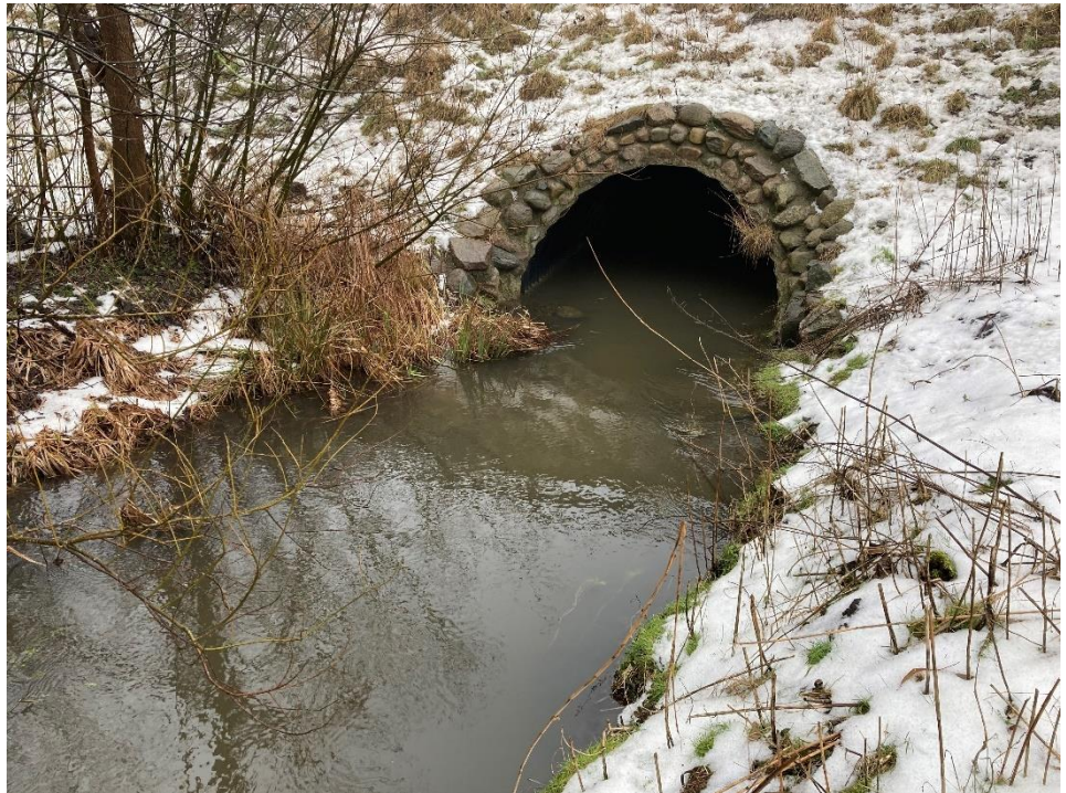
Figur 3-19: Passagen af Hovedvejen er omlagt i 2015 fra to rør til et stort korrugeret stålør med ubrudt vandløbsbund gennem. Foto NIRAS 2021-02-18
