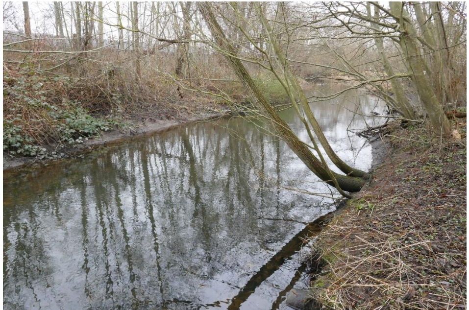
Figur 3-44: Ved Spangen opstrøms Priesesstræde er vandløbet fortsat kanaliseret, meget bredt og med ringe fysisk variation. Vandløbet er beskyttet fra begge sider og der er således ingen vegetation til at indsnævre vandløbet og skabe variation. Foto: NIRAS 2021-03-29
