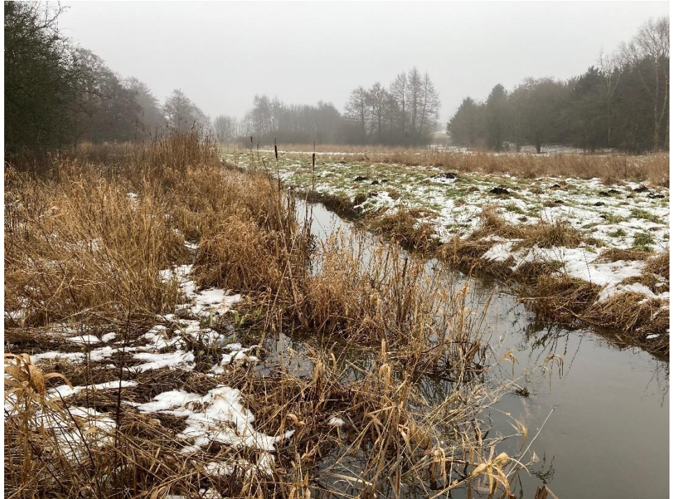
Figur 3-14: Hvor vegetationen har fået lov at indsnære profilet v. skånsom vedligeholdelse, har vandløbet snævret sig ind. Vandløbet er fortsat reguleret og forlagt til ådalens side. Foto: NIRAS 2021-02-18
