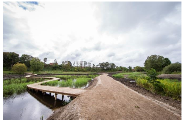
Klimasikring af Sillebro ådal med ådiger
