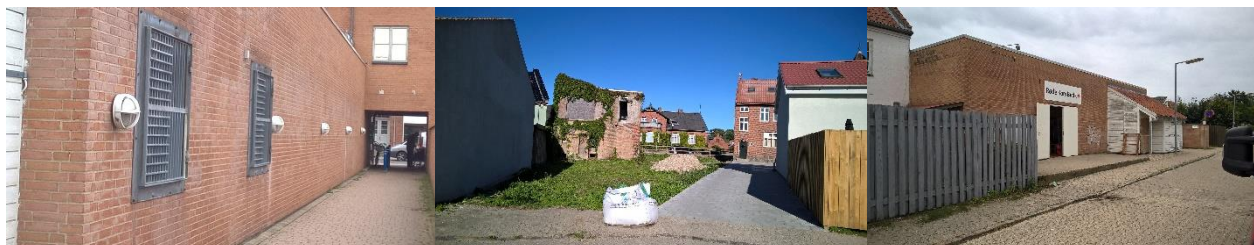
Billederne viser et eksempel på en eksisterende passage, brandtomten samt et udsnit af bagsiden af Jernbanegade ud mod Meny. Foto: Milena Rudez, Faxe kommune
