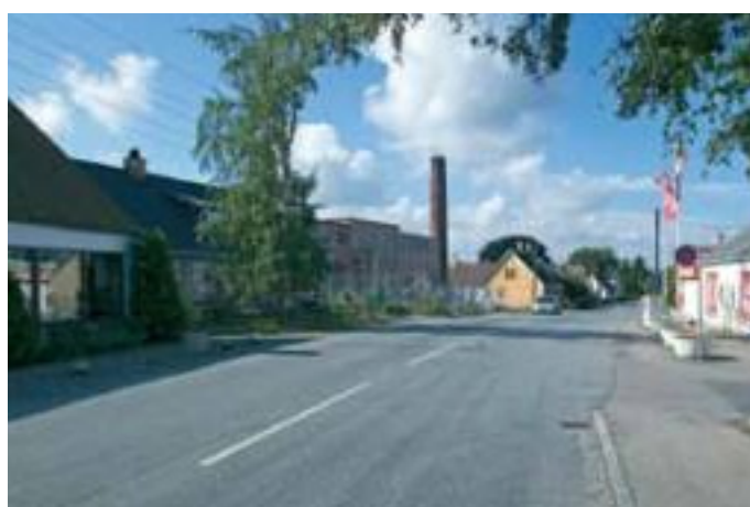
Området ved brugsen og mejeriet opleves som Fanefjordgades "centrum" og markeres flot af skorstenen. Mejeriet benyttes ikke idag, da dens stand er meget dårlig. Den forsømte bygning præger helhedsoplevelsen af stedet.
