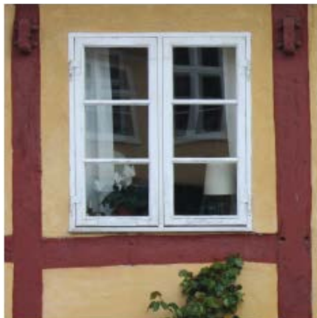
Vinduer med enkeltglas har spinkle, fine sprosser. Fortsrammerne viser sig kun som en svag dobbelt spejling af vinduerne i huset overfor
