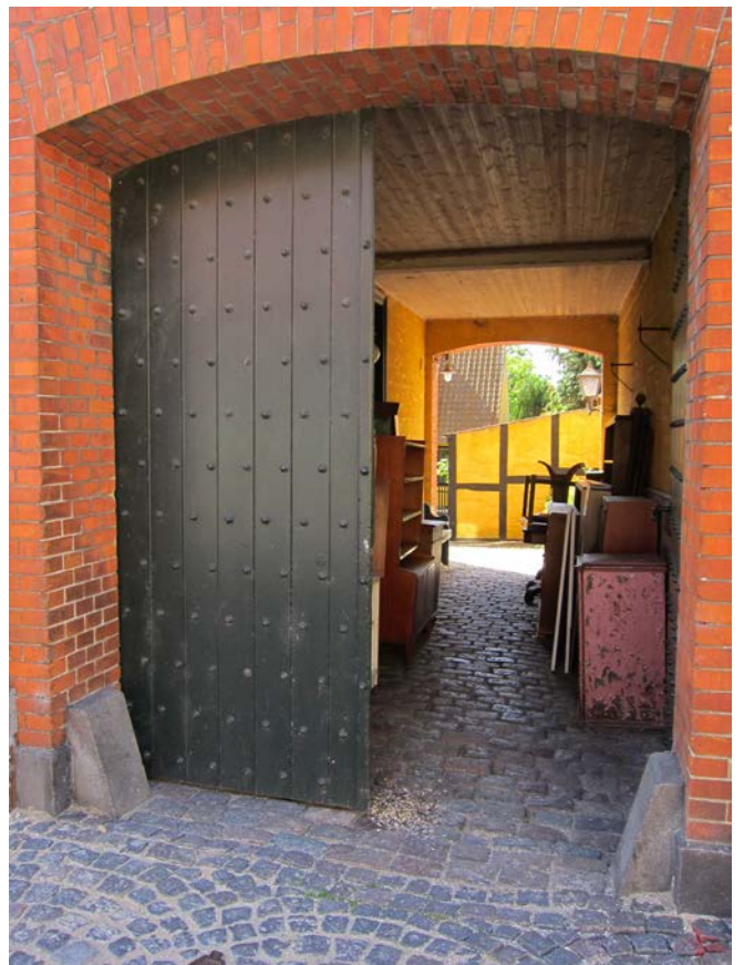
Omhyggeligt udformet revleport med drejede træknapper i en fladbuet portåbning med muret stik.
