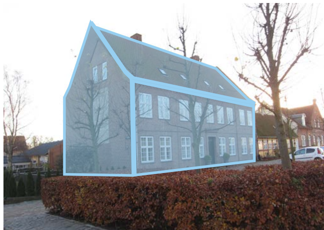
Smuk afklaret bygningsform eller bygningskrop som det også hedder i fagsprog. En forholdsvis høj bygning, der ligger ud til et torv medvirker til at definere byrummet. Bygningskroppens flader er markeret med blå.
