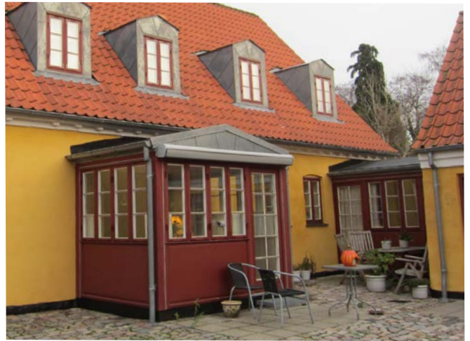
To eksempler på udestuer, der er integreret i eksisterende bebyggelse, materialer og byggestil er forsøgt inddraget.
