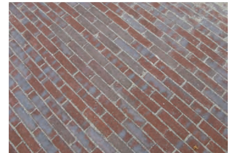
"Den røde løber" fra Slotstorvet til Voldgade anlægges i teglsten.
